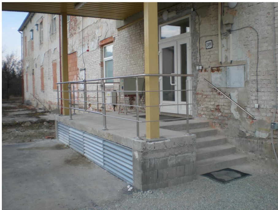
Obrázok 8: Rekonštrukcia budovy detašovaného pracoviska SNK vo Vrútkach
